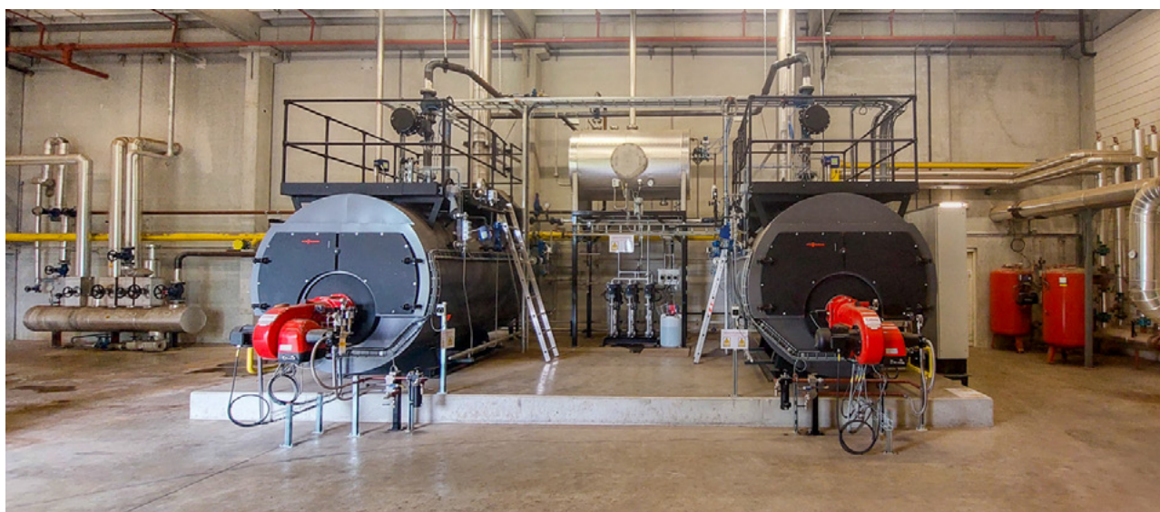
2 stoomketels van 5 T/h in cascade-opstelling, met hoogrendementsontgasser
